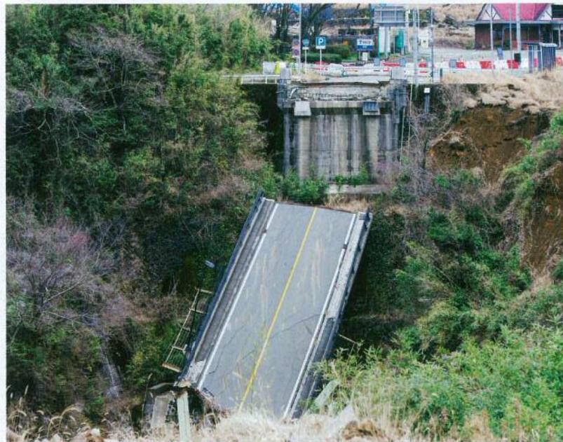
昭和46年に架設された阿蘇大橋は、橋台と桁の一部を残して谷底に姿を消した
