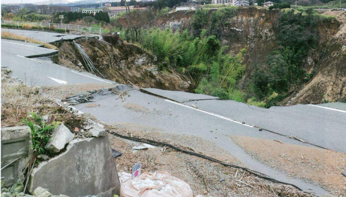
阿蘇大橋付近で寸断された国道57号。その西側では4車線のうち3車線が崩落し、残る1車線には亀裂が入った
