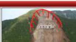
◆斜面中腹には、落石や不安定土砂の崩落対策として土留盛土を設置します
