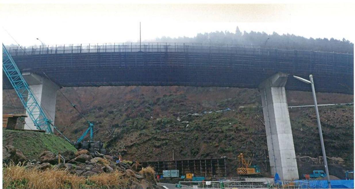
▲ 大切畠大橋（形式：鋼 5 径間連続鋼桁橋 橋長：265.4m）復旧工事
