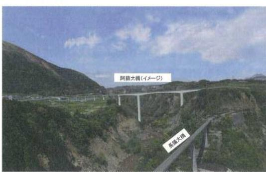
図-7 阿蘇大橋の架替イメージ（PC3 径間連続ラーメン箱桁）
