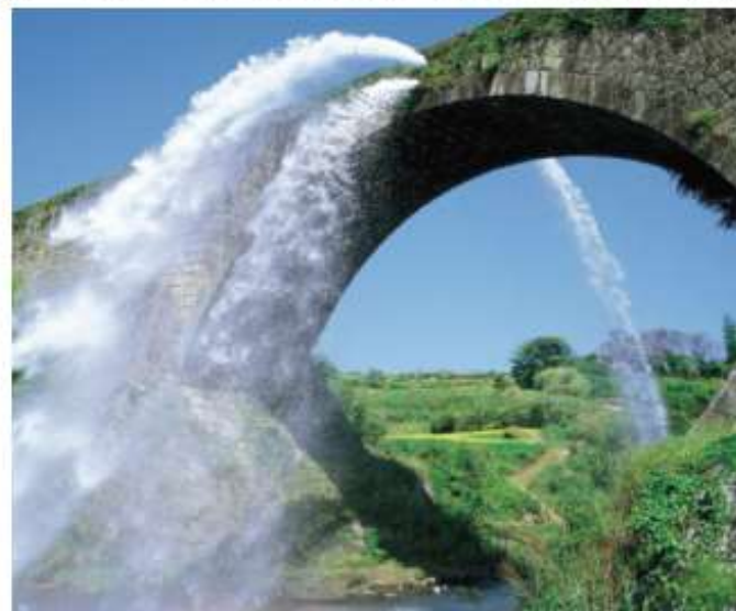
通潤橋(出典: https://tsujunbridge.jp/ )
